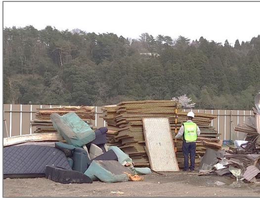
仮置場設置の技術的助言（穴水町）
