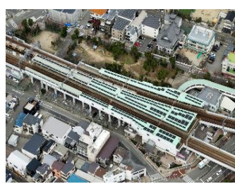
大物駅に導入された太陽光発電
