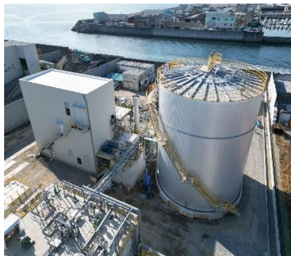
メタン発酵による廃棄物処理施設/神戸市
