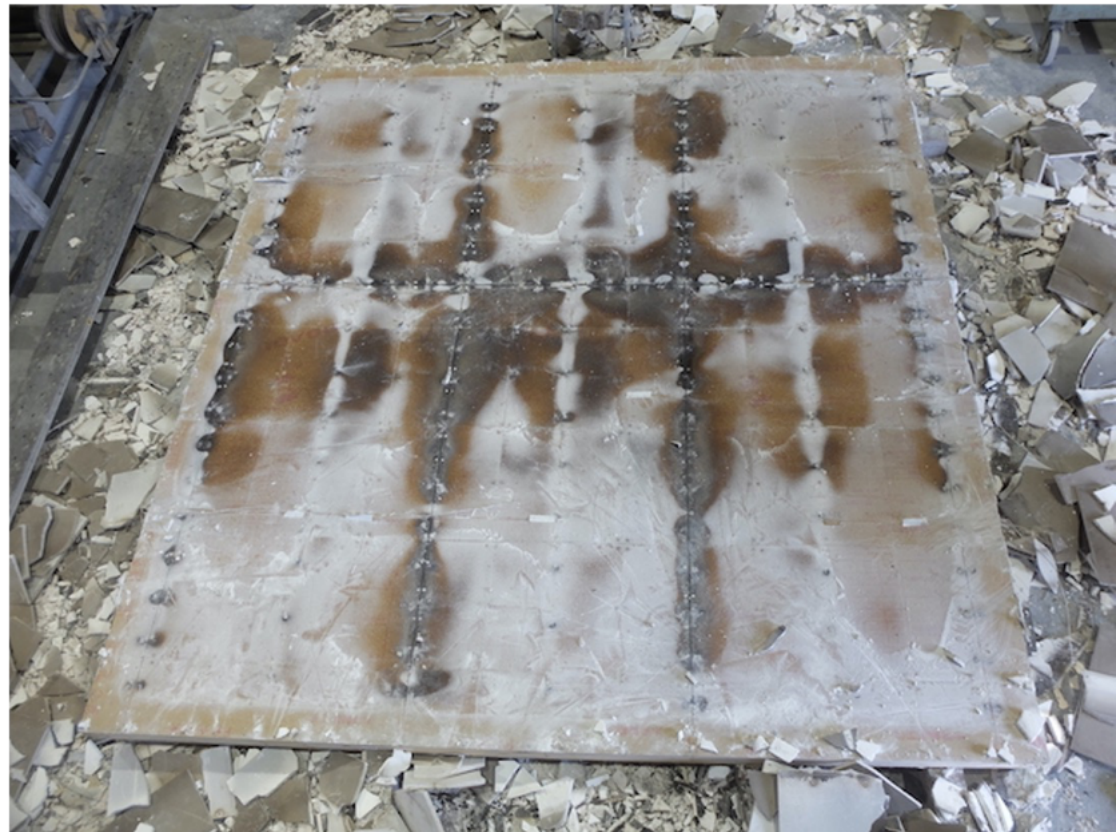
図12 耐火試験後の下地表面の様子
