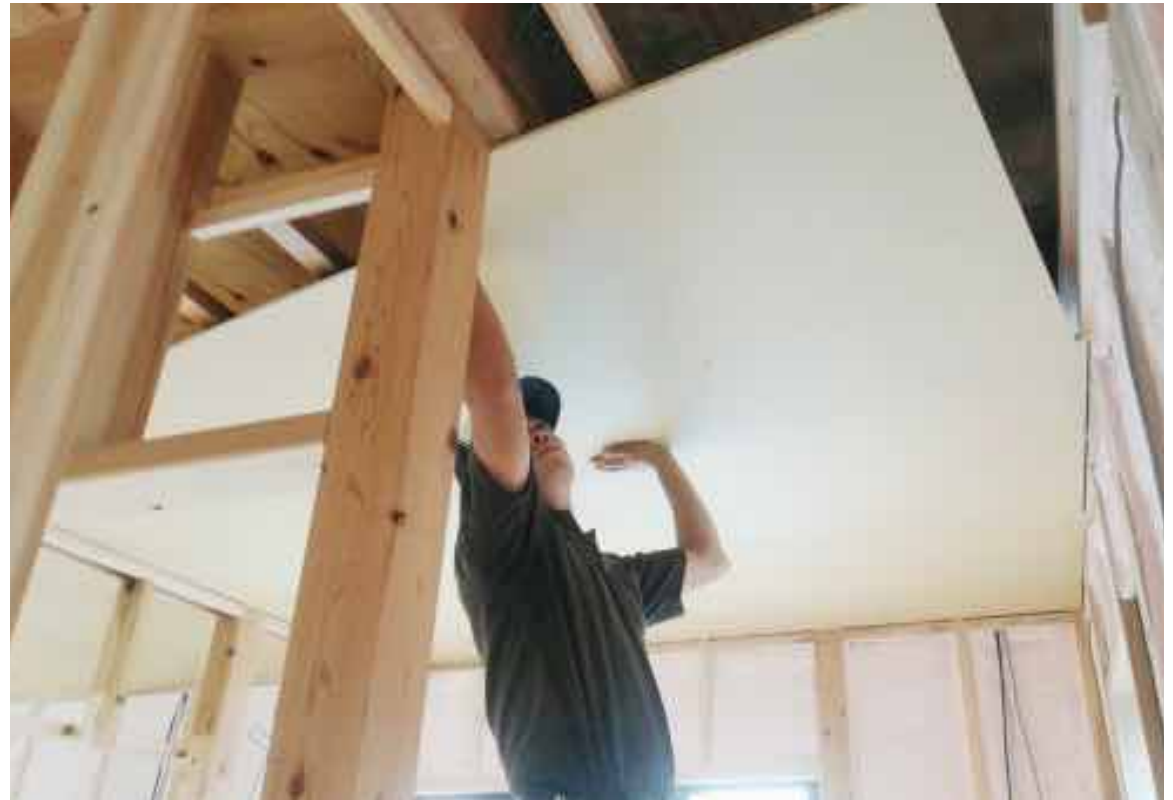
石膏ボード施工の様子
