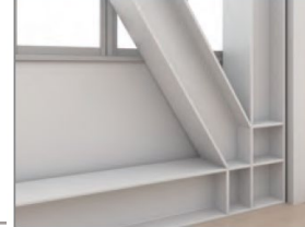
鉄骨ブレース構法
