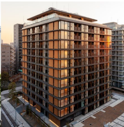
FLATS WOODS 木場 (弊社)
