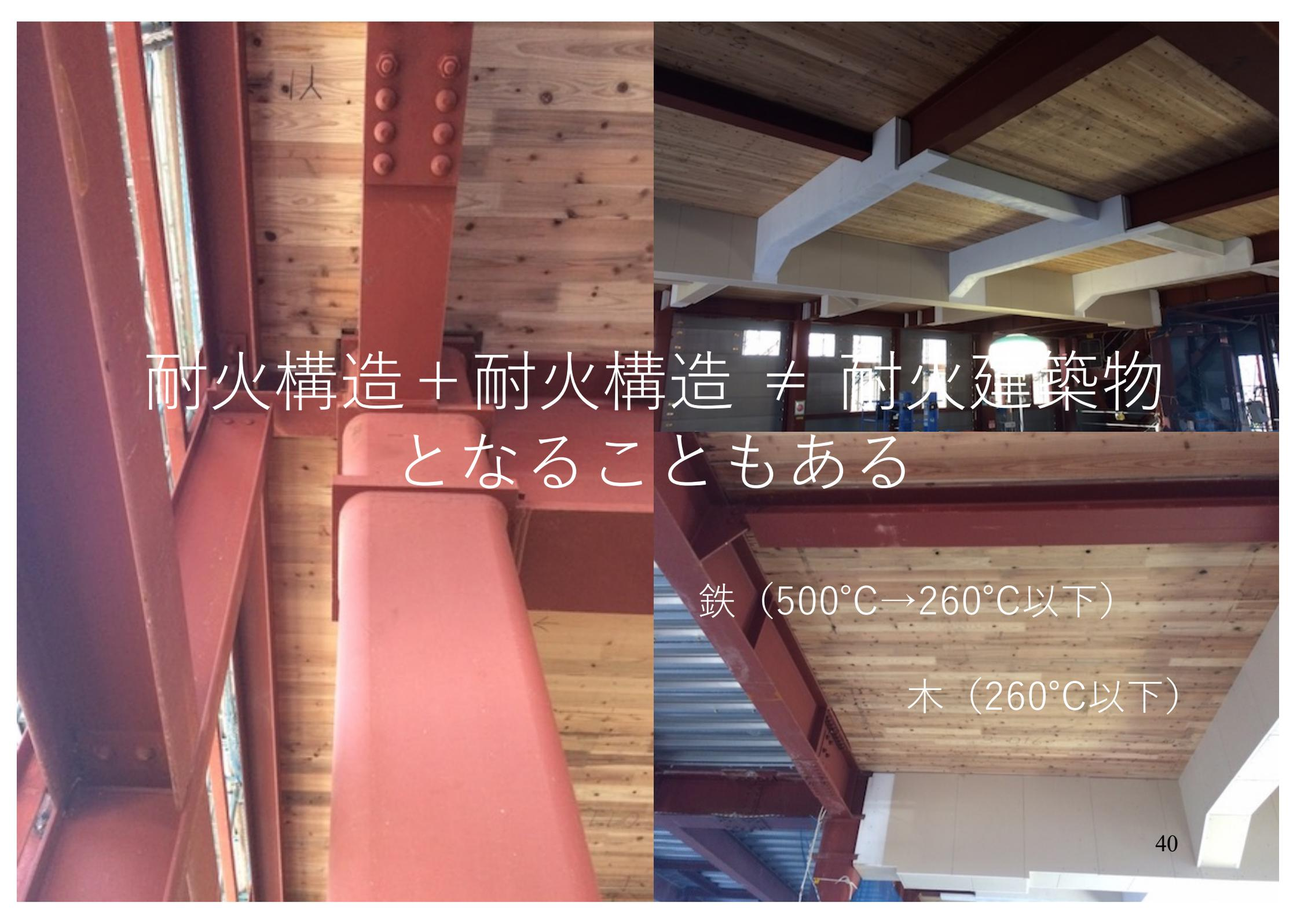
耐火構造 + 耐火構造 ≠ 耐火建築物
