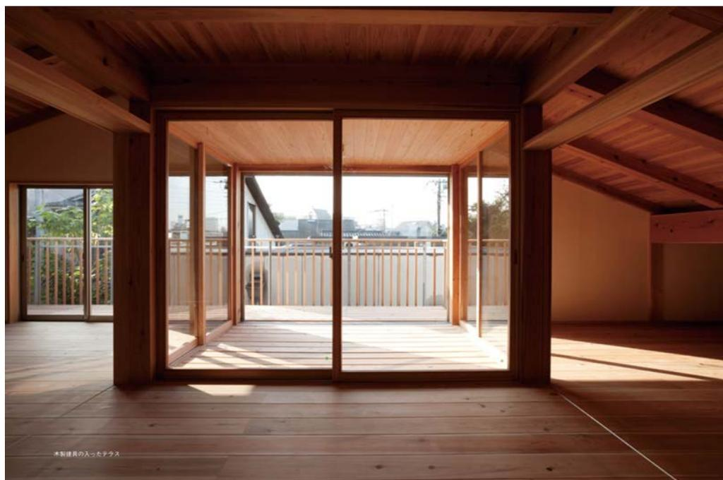
燃えしろ設計した製材の柱・梁
